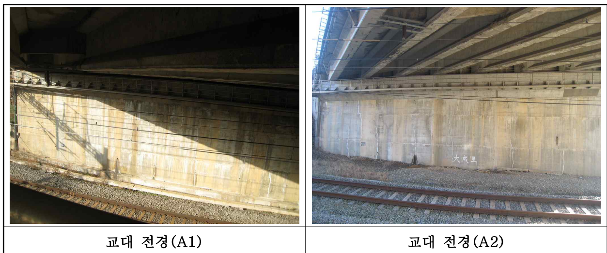
【사진 5.3.8】 교대 전경
