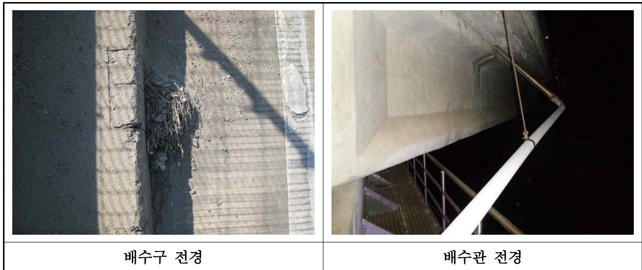
【사진 5.3.19】 배수시설 전경
