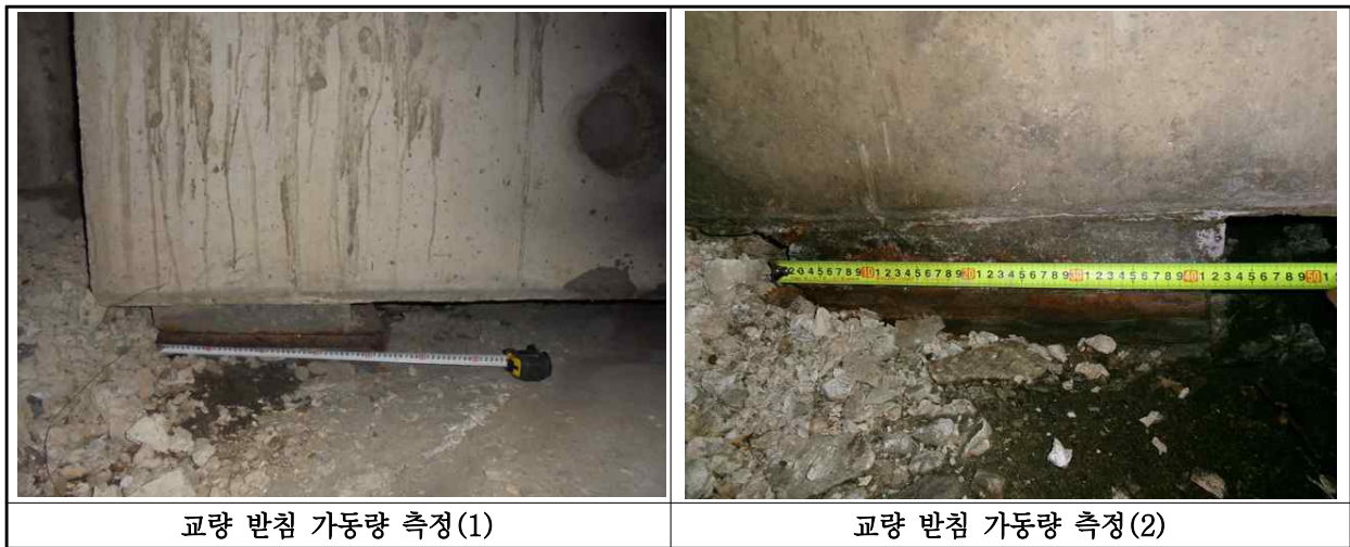
【사진 5.3.13】 교량받침 이동량 측정
