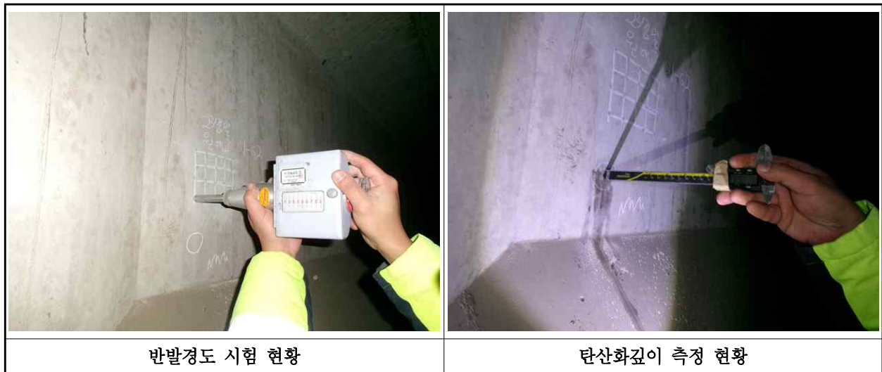
【사진 5.4.1】 콘크리트 내구성조사 현황
