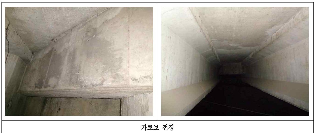
【사진 5.3.6】 가로보 전경
