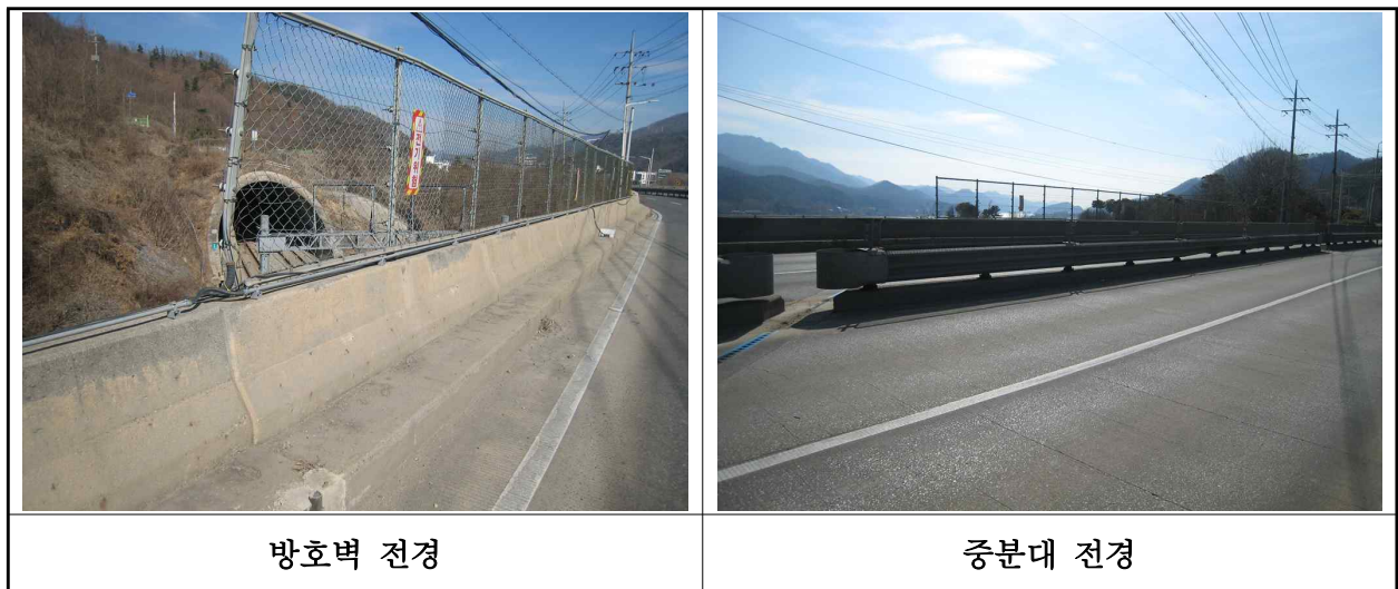
【사진 5.3.21】 방호벽 및 중앙분리대 전경
